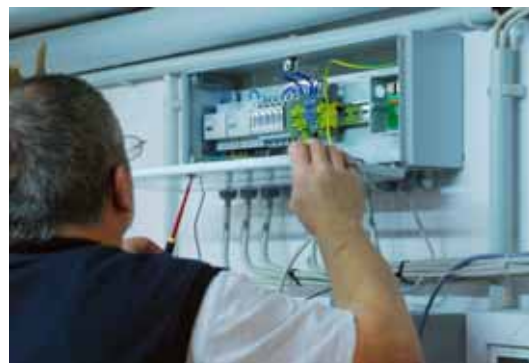
Bild 2: Inbetriebnahme des Elektrozählerkastens bei einer Wärmepumpenanlage
